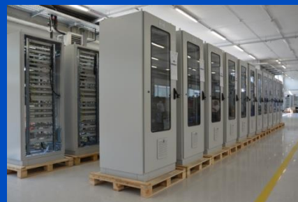
ALSTOM Tadjikistan SS Telecom
